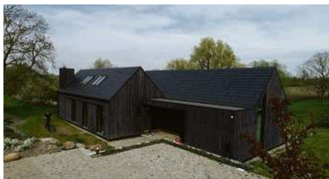
Wohnen mit der Natur: Beim Bau des Scheunenhauses achteten die Besitzer auf natürliche Materialien. Die Wände sind aus Holz, das Dach aus modernen rechteckigen Schiefersteinen. Fotos: Rathscheck
