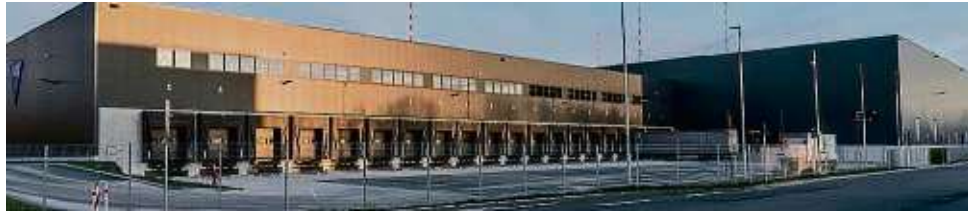
Eine Fassadenbegrünung gegen die „Lagerhallen-Optik“ wünschten sich Bürger und Grünen-Fraktion für die NTS-Erweiterung. Der Vorschlag wurde abgelehnt. FOTO: HAMPE
